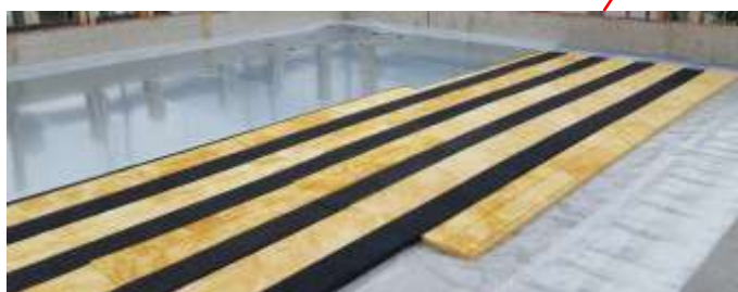
Bild 2: Sorgfältige Ausführung Streifenlagerung Gummigranulat / Mineralwolle
