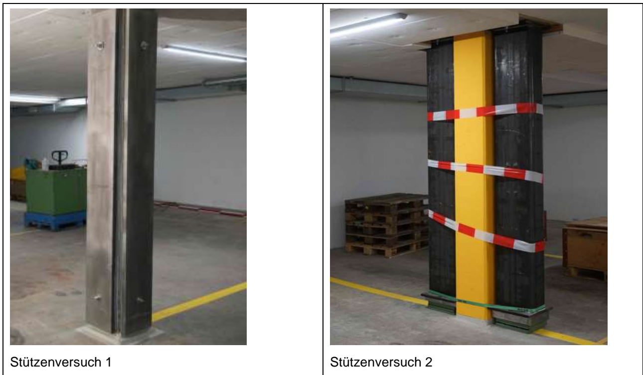
Bild 14: Fotos von versteiften Stützen
