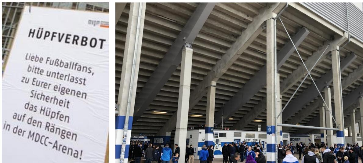
**Bild 8: Kurzfristige Lösung: Hüpfverbot; langfristig: Einbau zusätzlicher Zahn balken aus Stahl**
