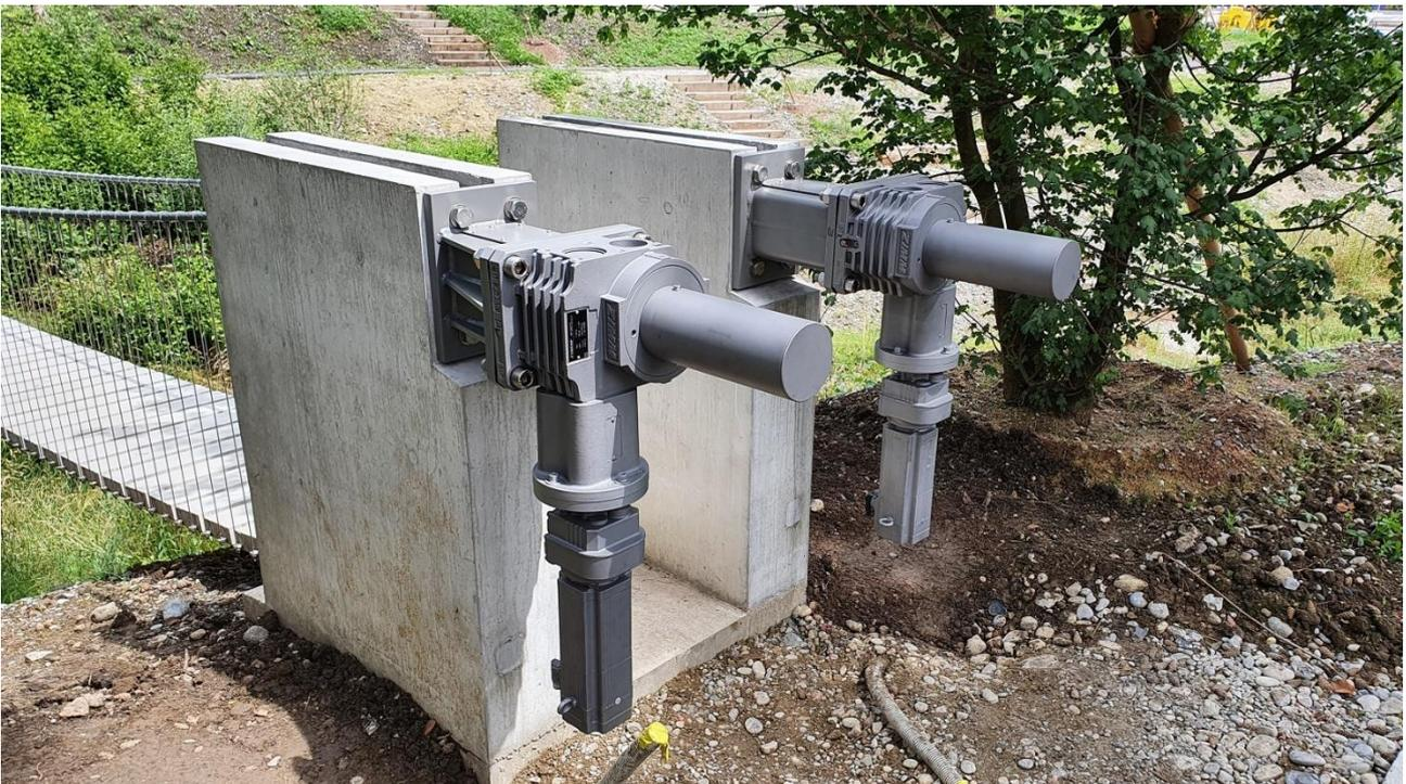
Abbildung 22: Mechanismus und elektrischer Motor.
