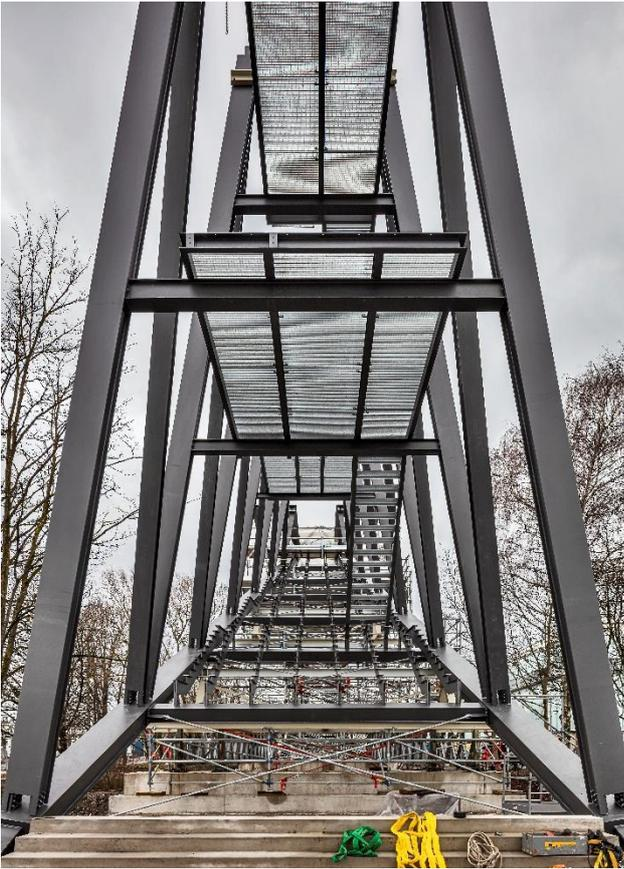
Abbildung 13: Plattformen im Innern und Unterkonstruktion der Treppe.
