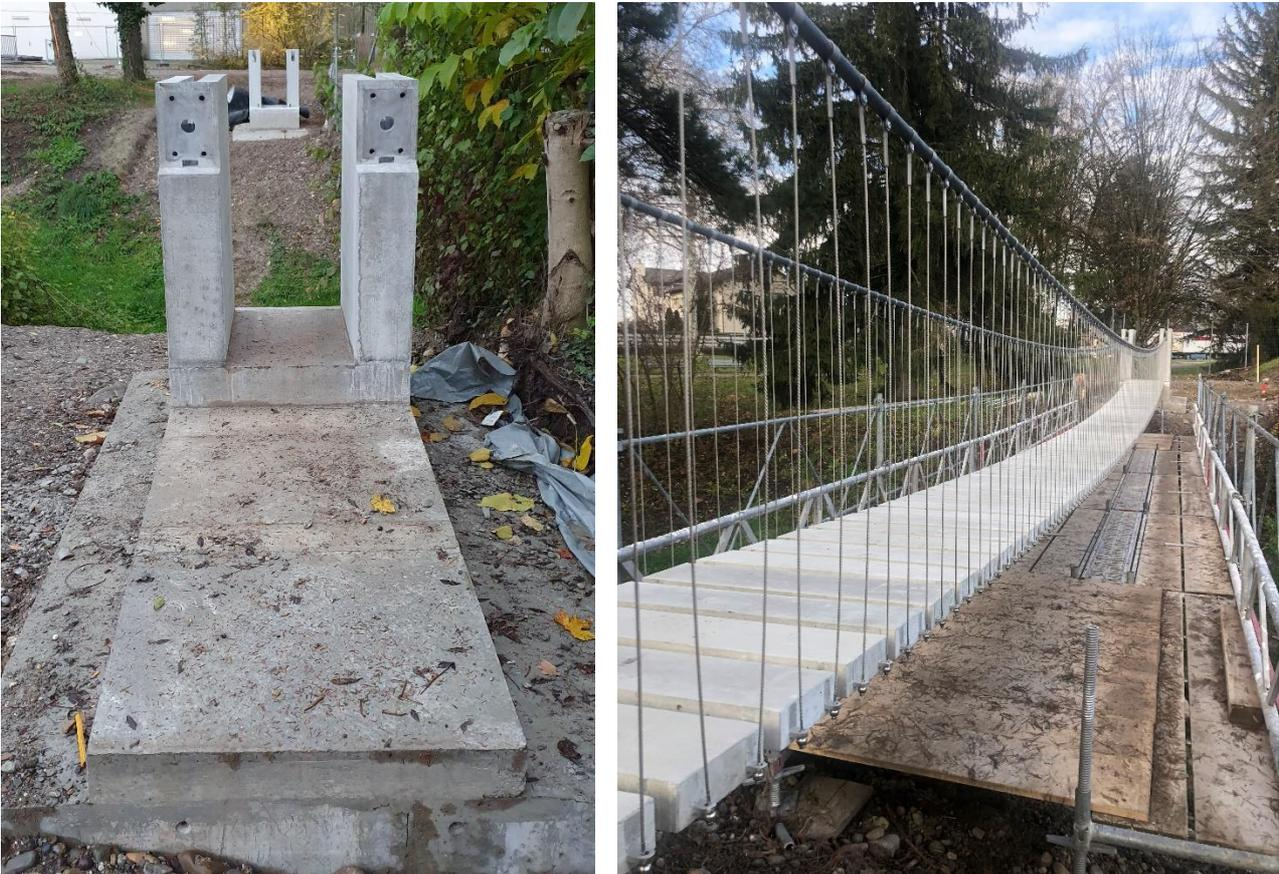
Abbildung 21: Hängebrücke mit Pylon (links) und Gehweg (rechts).
