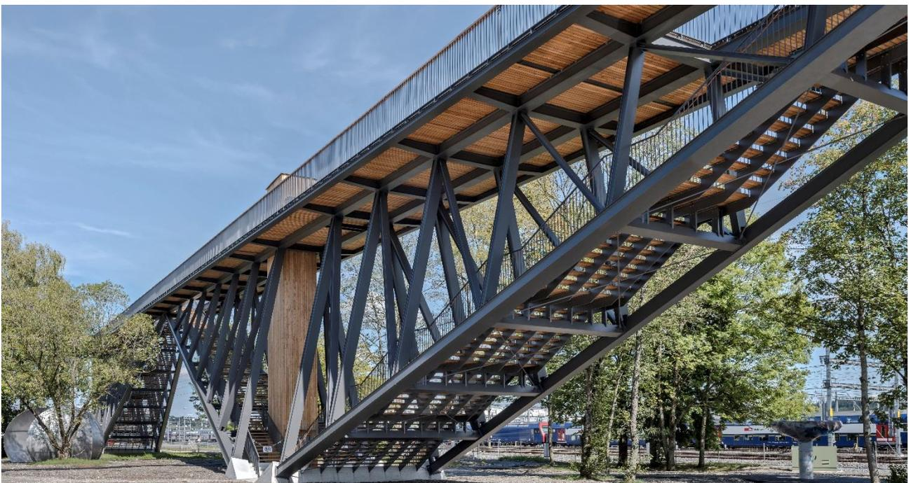
Abbildung 8: Fachwerk mit integriertem Aufzugsschacht.
