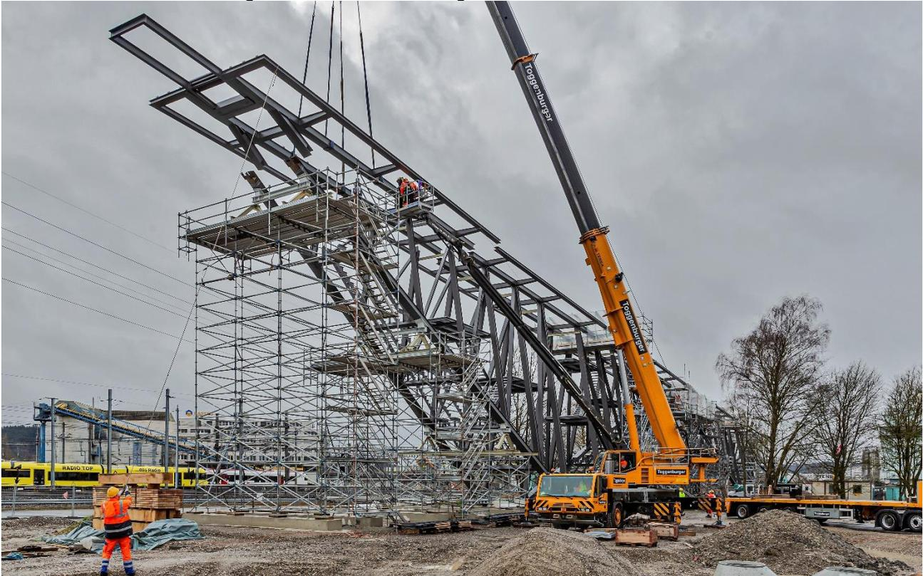
Abbildung 11: Montage eines Elementes des Vierendeelträgers.
