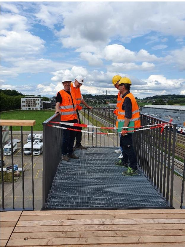
Abbildung 15: Kragbühne am oberen Ende der Brücke.
