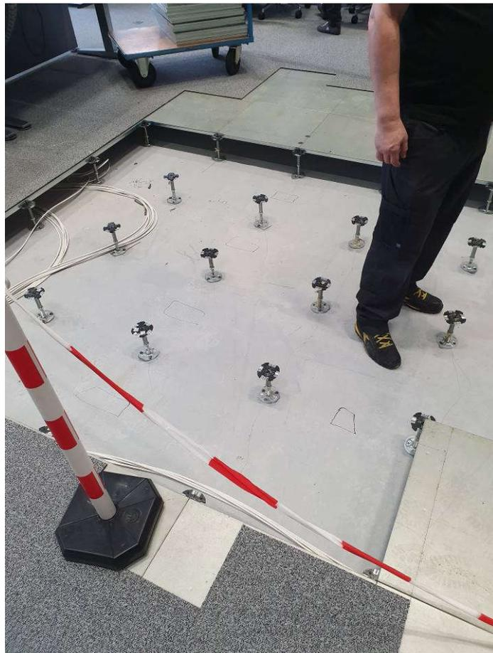
*Bild 9: Geschosdecke mit den Stützen des Hohlbodens bei entfernten Abdeckplatten in der Mitte des Deckenfeldes.*
