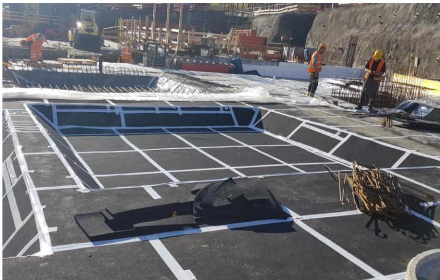
Abbildung 8: VIBRAX  DAMP Elastormatten wahrend der Baustellenmontage, Quelle: mageba SA.
