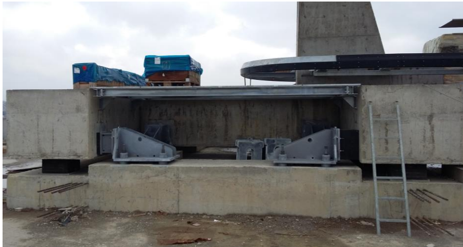
Abbildung 7: Seilbahnfundament wahrend der Bauphase, Quelle: Doppelmayr Seilbahnen GmbH.
