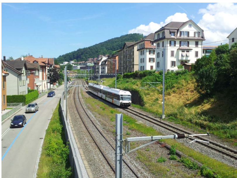
Bild 1.1 Eisenbahnstrecke durch Bruggen bei St. Gallen
