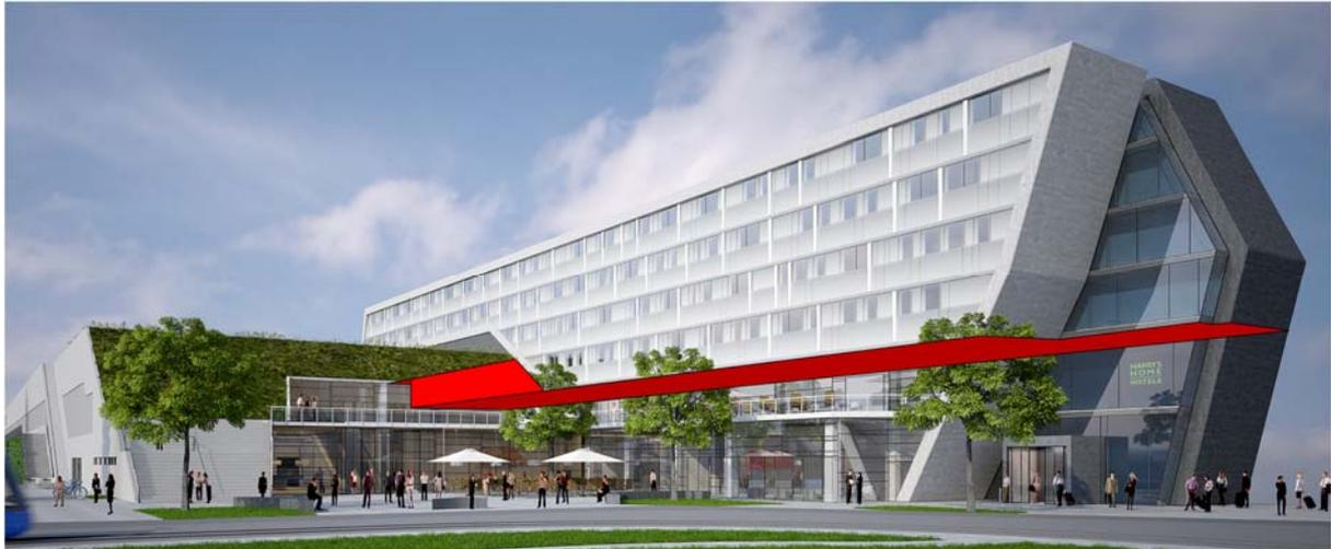
**Abbildung 1: 3D Animation des Bauvorhabens Hotel und Shopping Mall München-Moosach, Ebene der elastischen Entkopplung in rot darüber gezeichnet, horizontal unter Decke über 1. OG und Decke über 2. OG, sowie vertikal zum dreigeschossigen Gebäudeteil (Quelle: Pletschacher PE FMZ 1 GmbH & Co. KG, Eurasburg; Architektur: yes architecture, München)**
