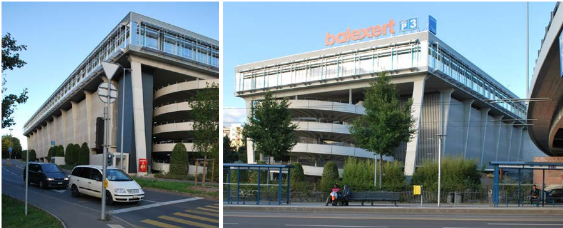
Bild 2: Weitere Ansichten des massiven sechsstöckigen Parkhauses.
