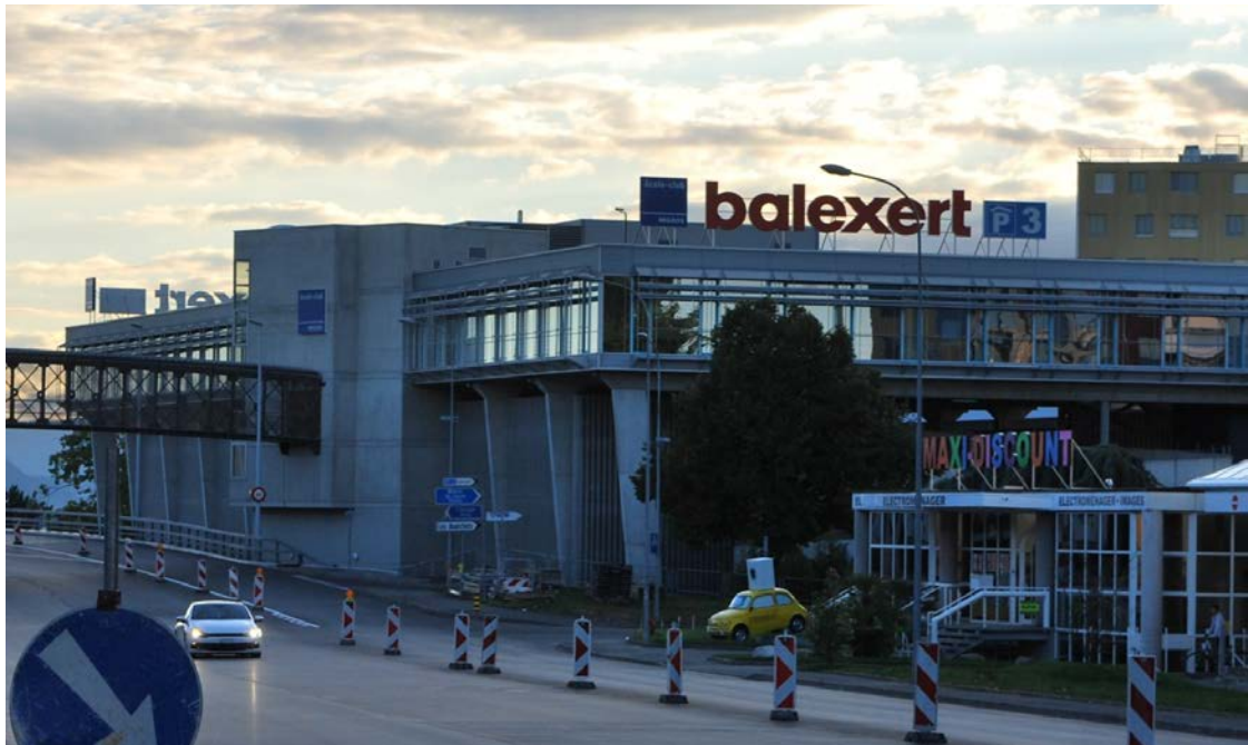
Bild 1: Massives sechsstöckiges Parkhaus mit Clubschule im obersten Geschoss. Der exzentrisch angeordnete Stahlbetonkern ist in der Mitte der linken Bildhälfte zu erkennen.
