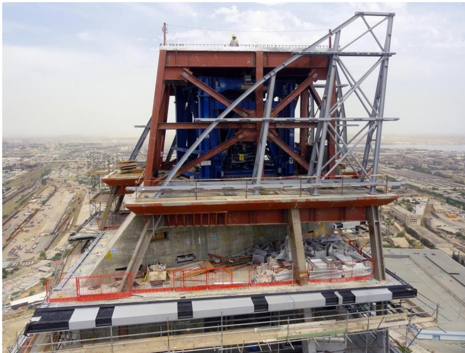
Abbildung 10. *foldedTMD* eingebaut im SOCAR Tower in Baku, Aserbaidshan.
