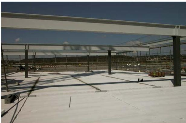
**Bild 1** Gasbeton-Platten für die Geschossdecke des Busterminal
