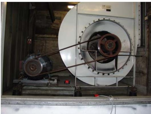
**Bild 3** Ventilator der Lüftungseinheit F-100
