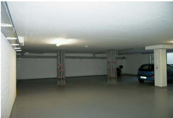
**Bild 3** Test mit 12 Baustützen zur Simulation der Verstärkung mit Stützen
