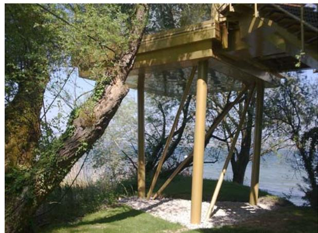
**Bild 4** Verstärkung durch Diagonalen
