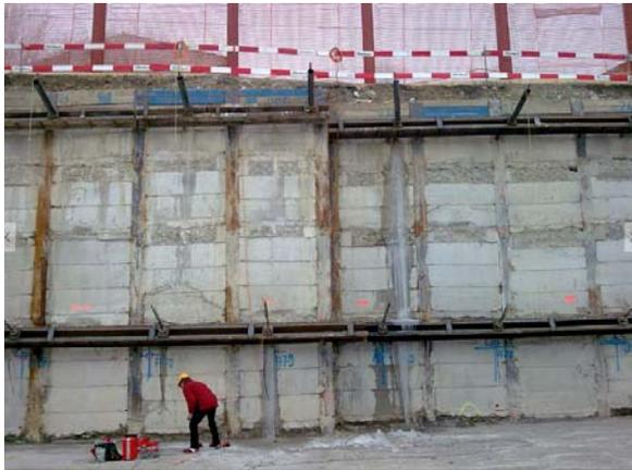
**Bild 1** Rühlwand gegen Bahn mit Messpunkt MP 1b
