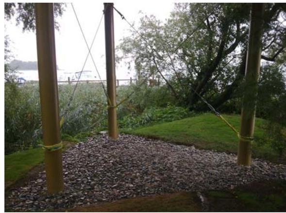
**Bild 2** Provisorische Verstärkung durch Abspannungen
