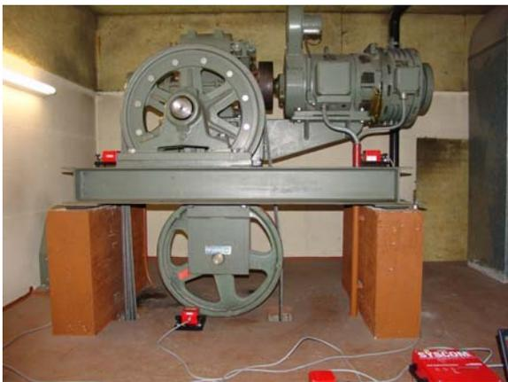
**Bild 1** Elastische Lagerung eines Liftmotors
