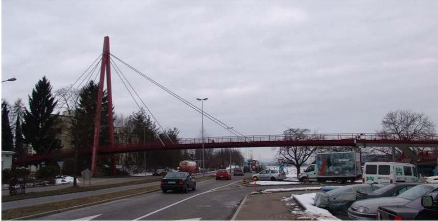
Abbildung 19: Schrägseilbrücke.
