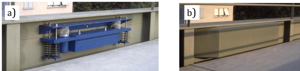
Abbildung 15: Balkenbrücke, a) im Längsträger eingebauter Schwingungstilger, b) Abdeckung des Tilgers.
