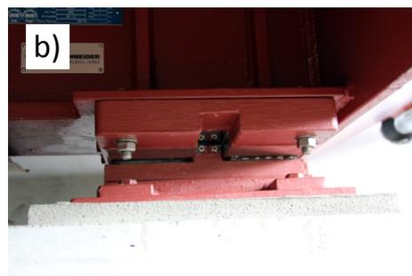
Abbildung 4: a) Provisorisches Lager, b) definitives verschiebliches Lager mit Gleitplatte
