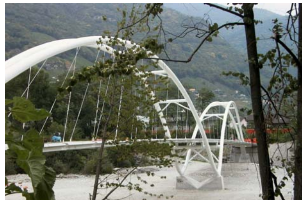
Bild 1.2 Fertige Brücke (noch ohne Geländer)
