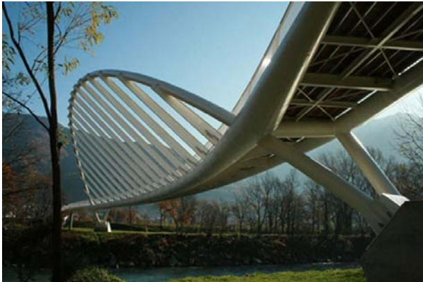
Bild 7.1 Fussgängerbrücke über den Fluss Ticino bei Carasso
