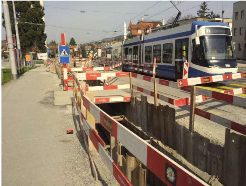
Bild 3.5 Temporärer Bodenschlitz an der Forchstrasse in Zürich
