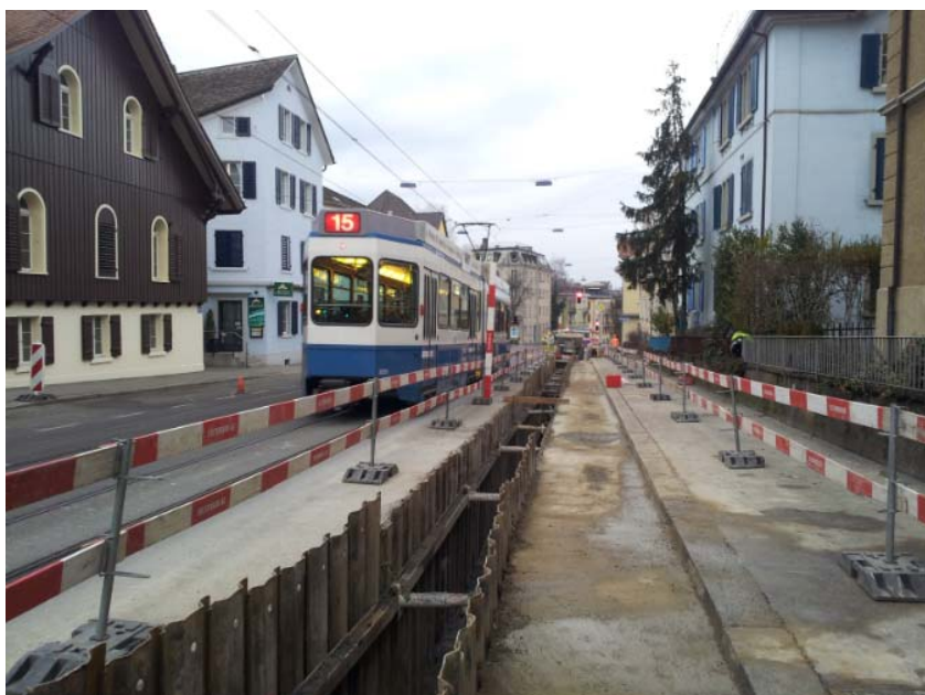
Bild 1.1 Temporärer Bodenschlitz an der Asylstrasse in Zürich
