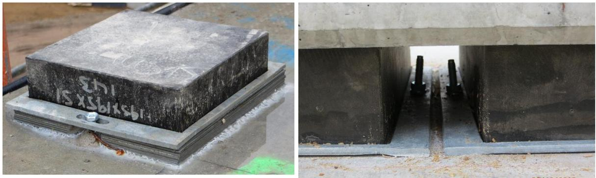
Abbildung 5: Fehlerhafter Lagereinbau Projekt QMP; links: Höhenausgleich durch nicht zugelassene, nicht normgerechte Futterbleche; rechts: Behinderung der Lagerverformung durch Schrauben
