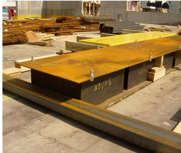
Abbildung 6: Projekt Seesicht; links: Mörtelbett mit Fliesmörtel zur genauen vertikalen Ausrichtung der Lager; rechts: Verlorene Schalung zur Verminderung des Aufwands bei der Holzschalung
