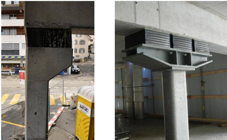
Abbildung 4: Einfluss der Lagerung auf angrenzende Bauteile; links: ungewollte Schiefstellung von Stützen infolge exzentrischer Lasteinleitung, rechts: Verdopplung der Knicklänge der Stütze durch die Lagerung
