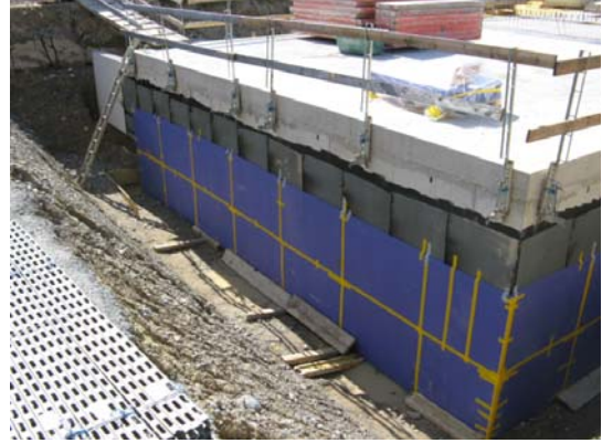
Verkleidung der Aussenwände mit PU-Schaum-Matten
