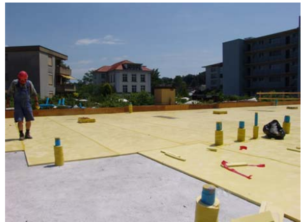
Verlegen der PU-Schaum-Matten über Parkhausdecke
