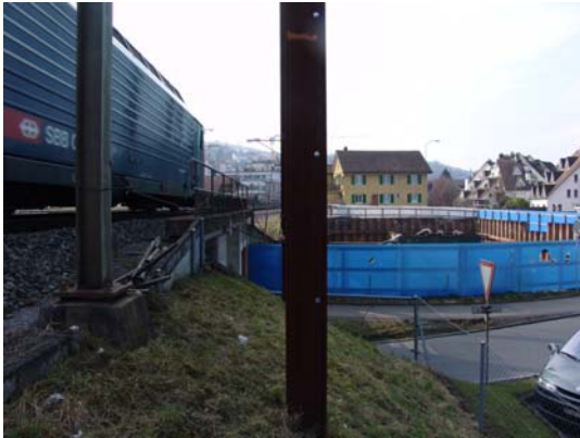
Baugrube neben Eisenbahnlinie
