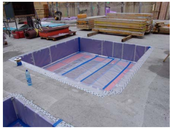
Auskleidung der Lift-Unterfahrt mit PU-Schaum
