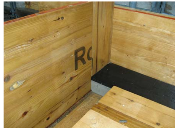
Fehlerstelle: Nicht-verkleidete Beton-Stirnseite
