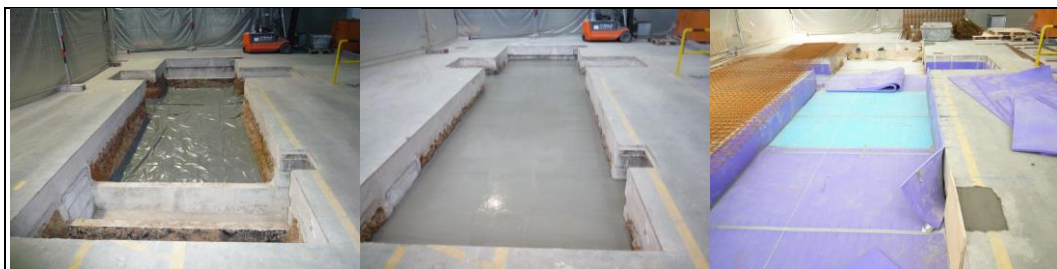
Bild 3 Beispiel eines Blockfundaments
