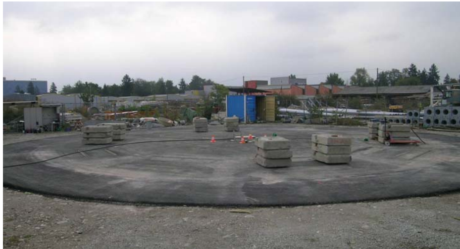
Bild 9: Versuchsstand: Deutlich sichtbar sind die Betonblöcke, welche die Polyurethan-MFS quasistatisch belasten.
