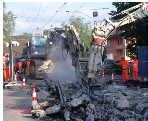
Gleisschlag Giesshübelstasse, Zürich
