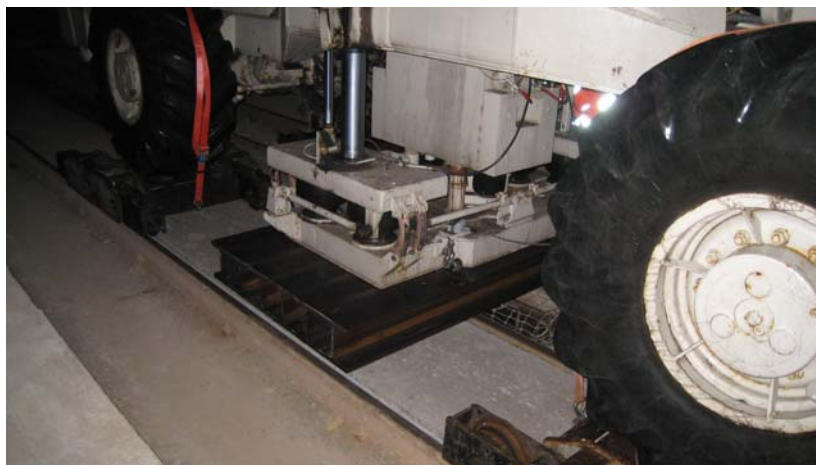
Abb.6: Anregungsposition im Gotthard Basis Tunnel mit Ausgleichsbeton und Stahlplatte zur Überbrückung des Drainage Kanals
