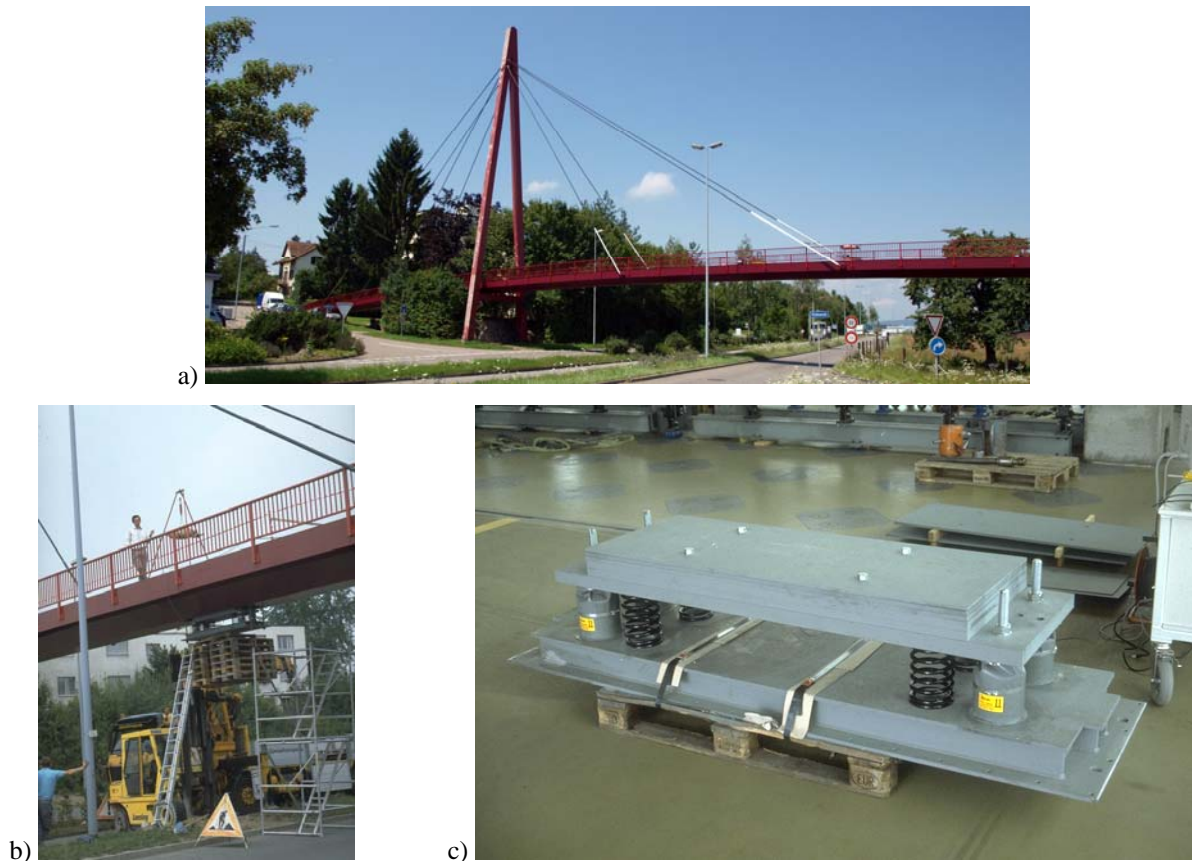
Abb. 7: a) Fussgängerbrücke über die Kantonsstrasse. b) Einbau des Schwingungstilgers in den Hohlkasten des Brückenlängsträgers. c) Schwingungstilger im Labor.
