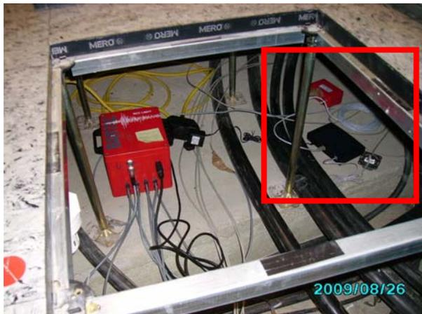
Bild A: Umspannwerk – GSHDSL-Router
