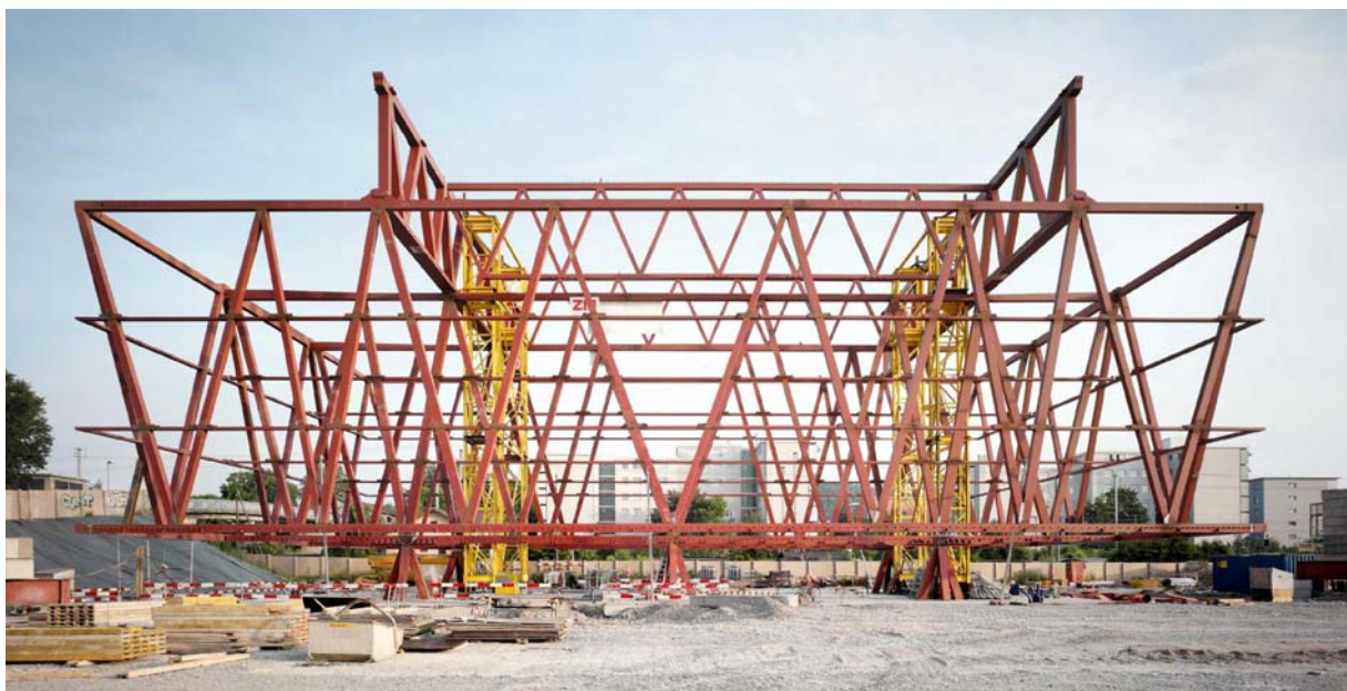
Abb. 4 Stahlfachwerke vor der Montage von Turnhalle und Dach
