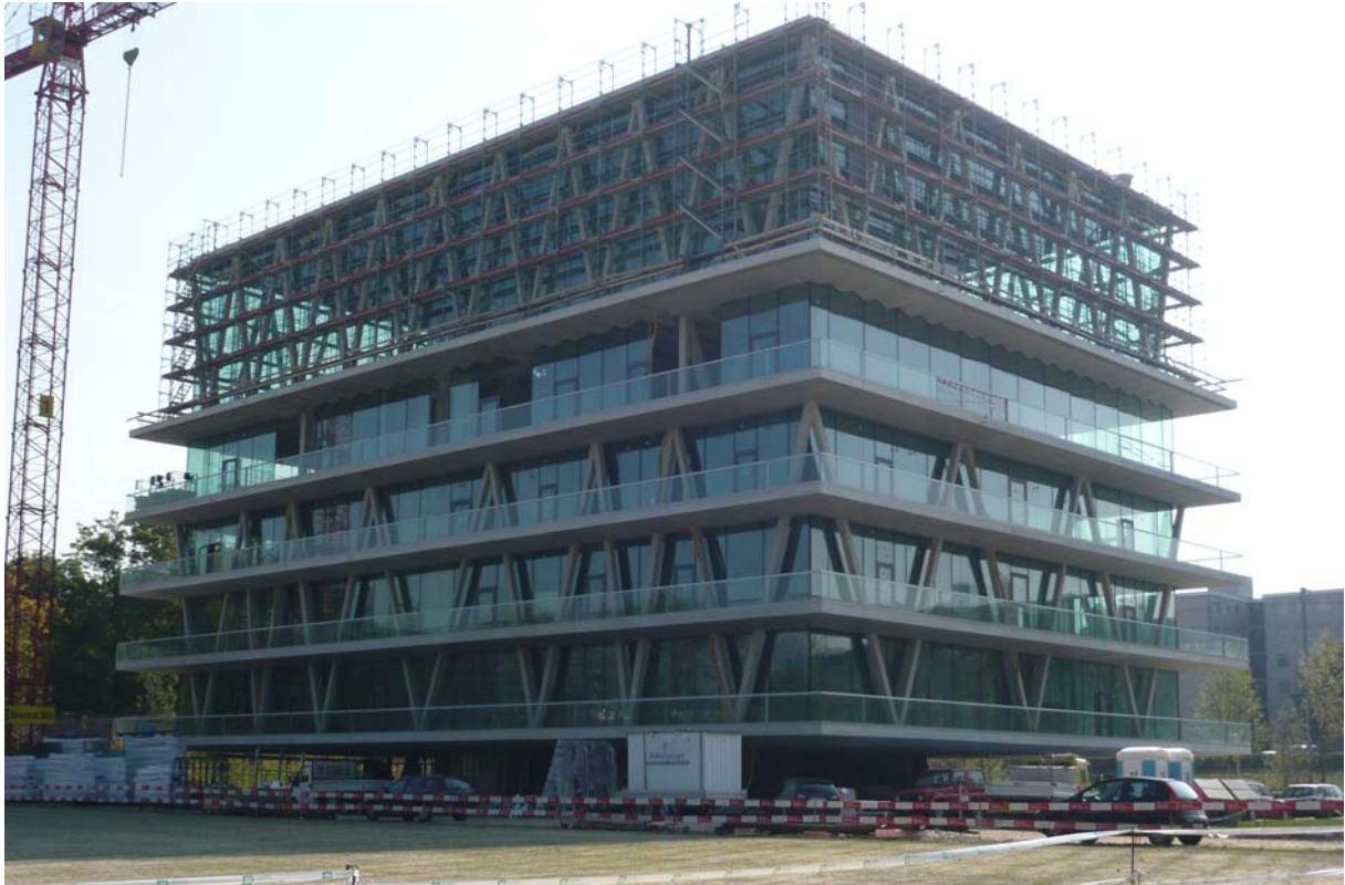
Abb. 11 Bauwerk von Nordwesten
