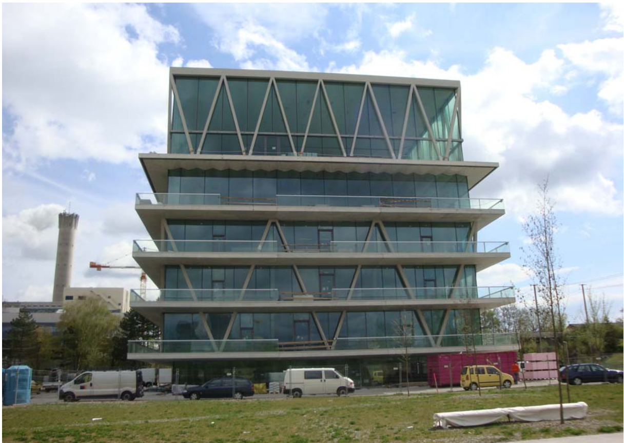
Abb. 12 Bauwerk von Westen (Stirnseite)
