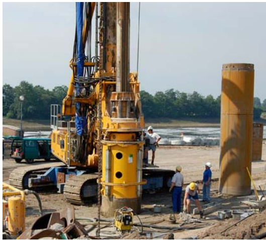
Bild 3.1a Bohrmachine mit Bohrrohren. Fallhöhe: 0.2 m Gewicht: 2'000 kg
