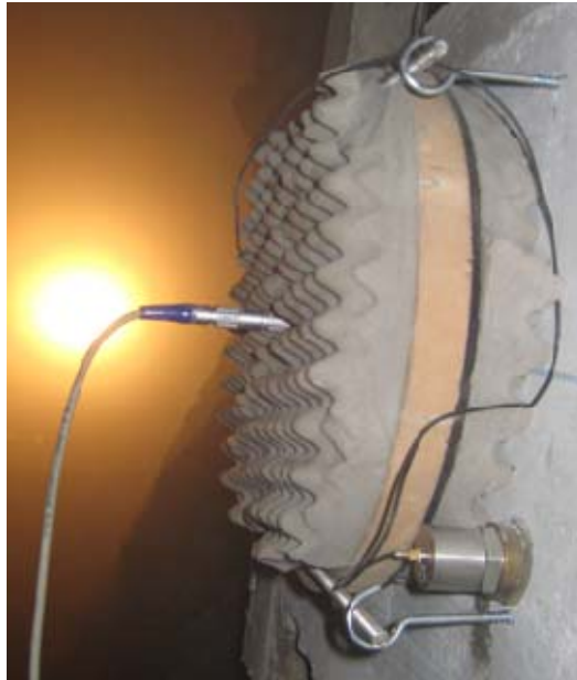
Verschluss Kernbohrung und Mikrofoneinsatz vor Anbringung äusserer Abdeckung
