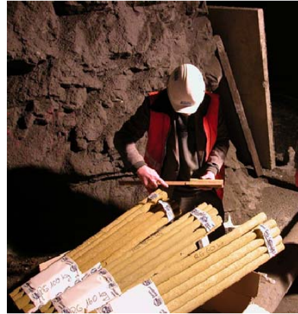
Steinwollstäbe für die Bohrlochverdämmung
