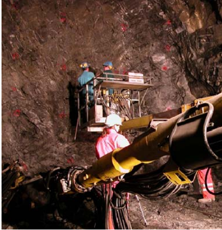
Laden der Bohrlöcher bei Versuch 1
