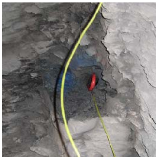
Sprengschnur reicht zum Bohrloch heraus
