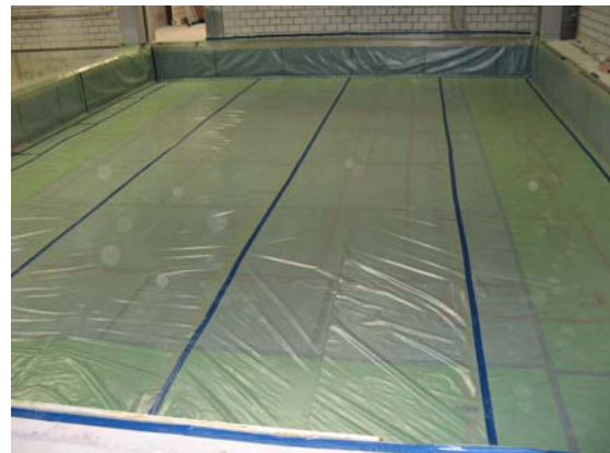
Fundamentwanne mit PU-Schaum-Auskleidung
