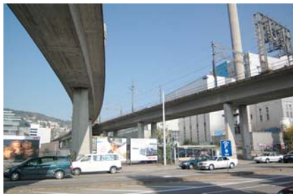
Bild 2 Viadukt der SBB und Pfingstweidstrasse
