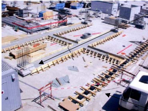
Abfangkonstruktion auf dem Stützenraster
