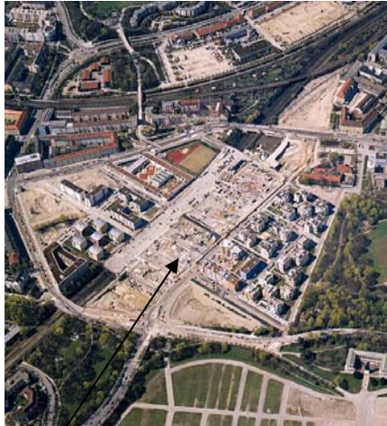
Gesamtüberbauung Theresienhöhe München
