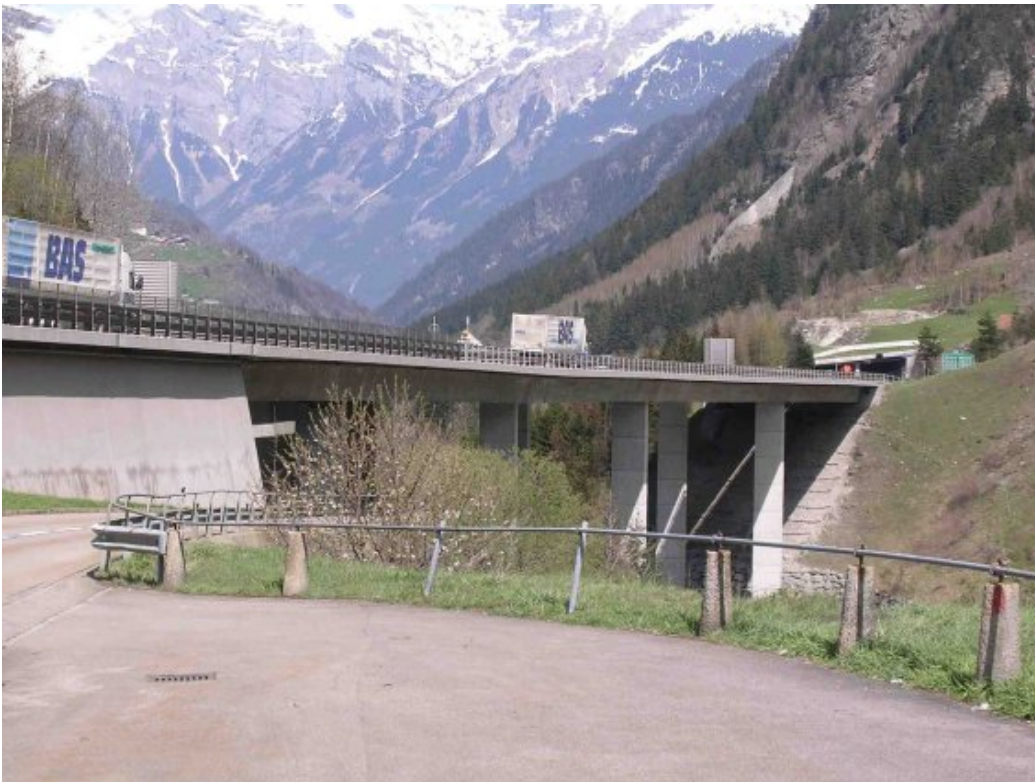
Bild 3: Die Reussbrücke der A2 im Kanton Uri
