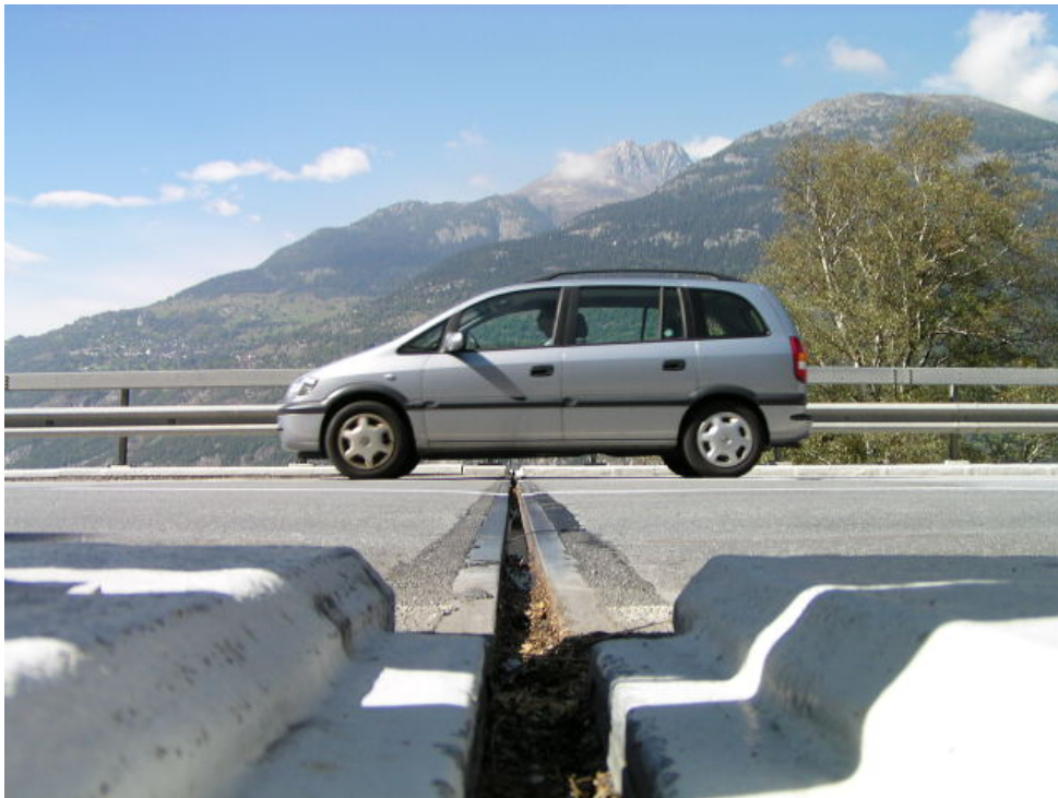
Abb. 4-2 Fahrbahnübergang Lingwurmbrücke Seite Brig-Glis
