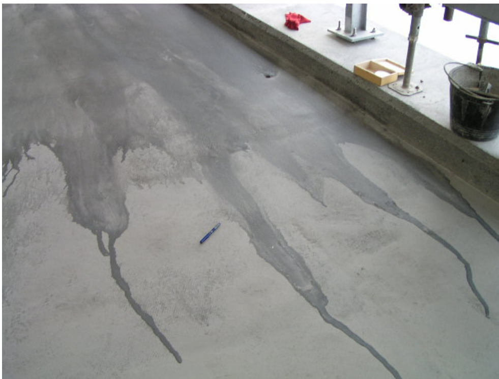
Abb. 3-2 dunkelgraue Modulausscheidungen bei der Ledischleifbrücke (Oktober 2003)
