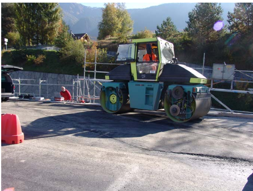
Abb. 4-6 Vibrationswalze (Gewicht 9.5 to) im Bereich der auskragenden Fahrbahnplatte
