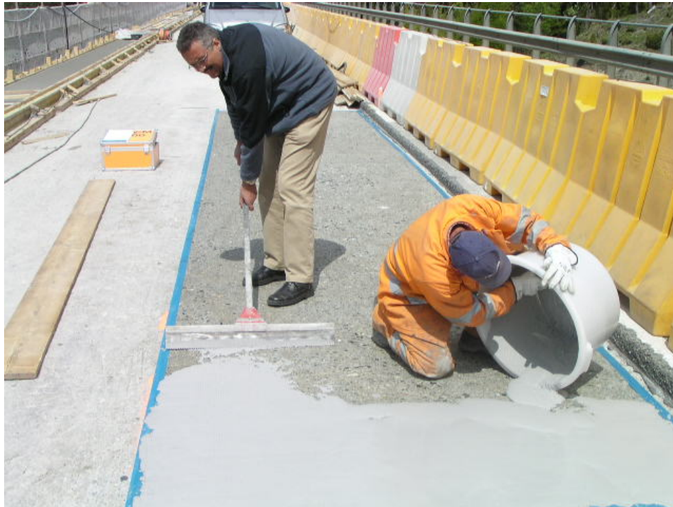
Abb. 3-3 Applikation des ECC-Mörtels auf der Versuchsfläche
