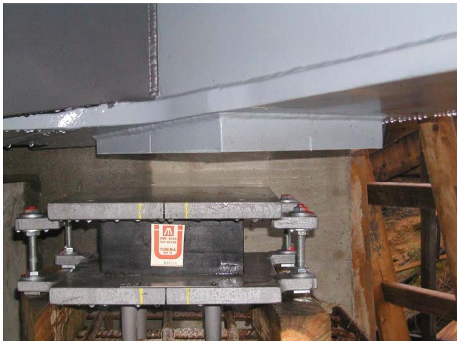
**Bild 6.5** Allseitig verschiebliches Elastomerlager
