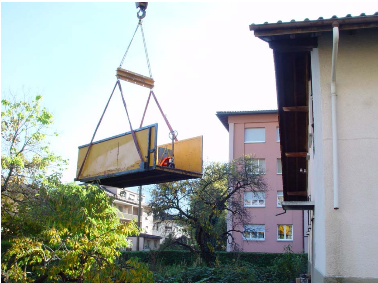
Abbildung 5: Mulde mit Schwinger wird gegen das Obergeschoss geführt.
