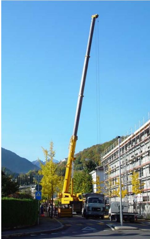
Abbildung 4: Kranwagen, welcher die Mulde mit Schwinger ans Haus hebt (links) und Schwinger in Mulde (rechts).
