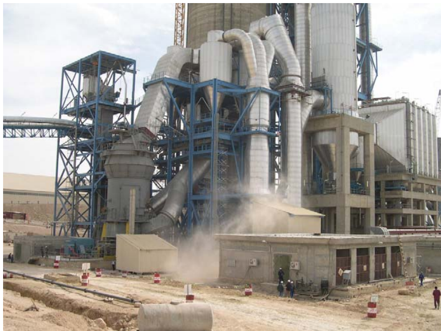
Bild 2: Zylinderförmige Walzenmühle Der zu Pulver gemahlene Kalk wird mittels heisser Luft und starken Gebläsen aus der Mühle in die dahinterliegenden Silos transportiert. Rechts von der Mühle steht die Unterstation mit den von aussen zugänglichen Transformatoren und den Steuerschränken im Innern.
