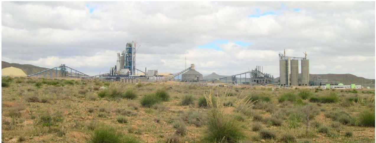
Bild 1: Ansicht des Zementwerkes in M'Sila Deutlich sichtbar ist von links nach rechts: Rohstofflager, Förderanlage für Rohstoffe, Kalkmühle und Silos der Ausgangsstoffe für den Rohrofen, Rohrofen, Klinkerlager, Förderanlage mit Klinkermühle, Zementsilos
