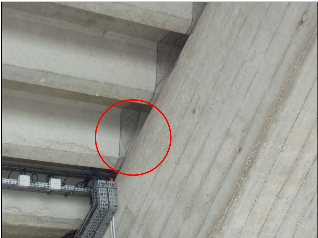
Abbildung 2 Sanierungsmassnahme im Stadion Parc des Princes
