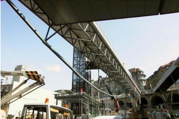
Bild 4.1a Fussgängerbrücke mit Unterspannung
