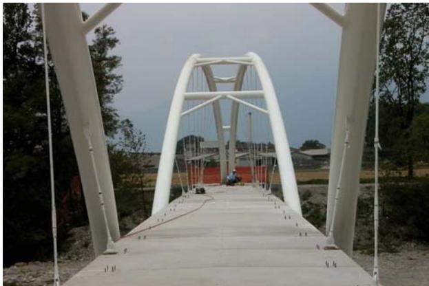
**Bild 9.5a** Schwingungsmessung ohne Geländer
