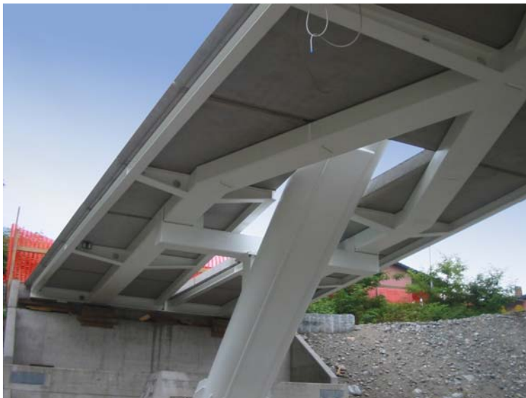
Figure 2.4: Vue en correspondance de la culée
