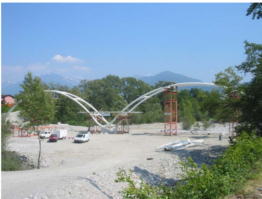
Figure 2.2: Structure porteuse principale en phase de montage
