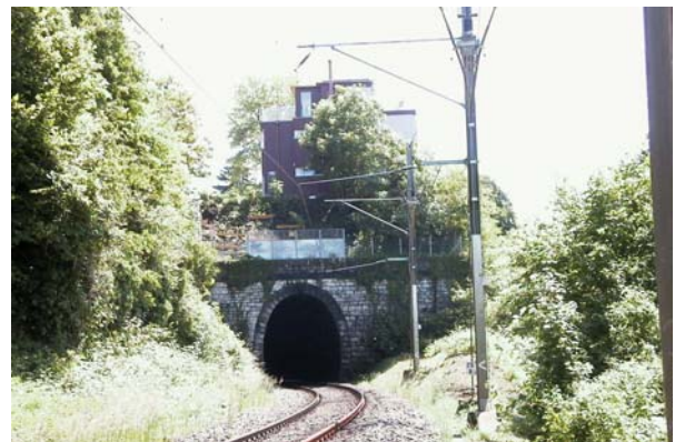
Bild 6.1b Tunnelportal unmittelbar vor dem Gebäude Felsenburg
