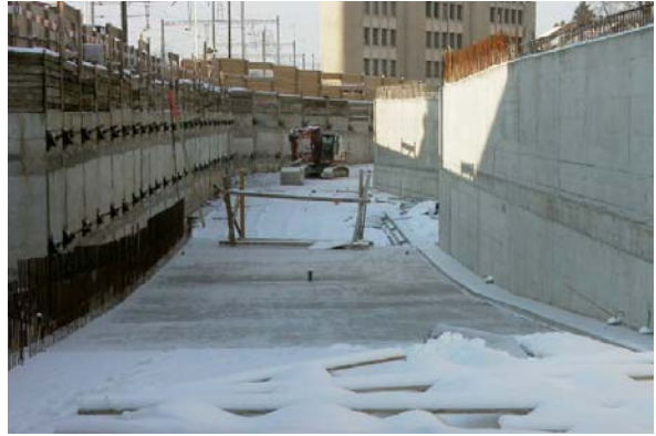
Bild 6.6b Zufahrtsrampe durch elastische Fuge vom Gebäude getrennt
