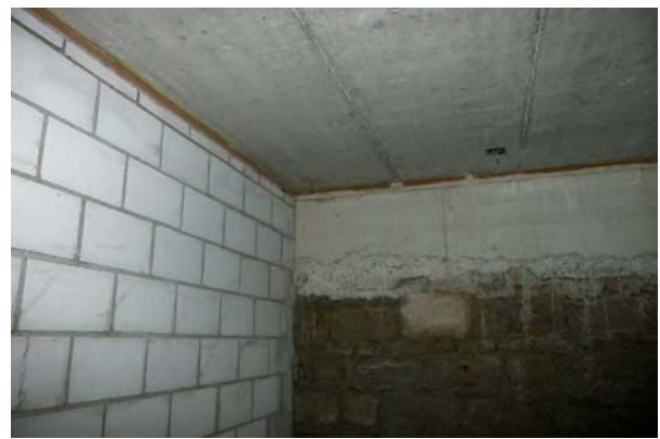
Bild 6.1d Elastische Lagerung der Innenmauern mit Sylomer-Streifen
