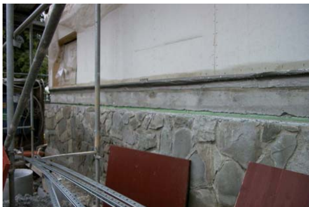
Bild 6.1c Elastische Lagerung der Aussenmauern mit Sylomer-Streifen
