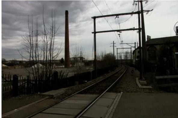
Bild 6.6a Gelände vor Baubeginn
