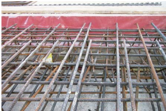
Bild 6.6c Elastische Fuge zwischen Rampe und Gebäude vor dem Betonieren der Rampe
