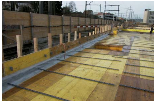
Bild 6.6d Elastische Lagerung der Decke über der Zufahrtsrampe vor dem Verlegen der Armierung
