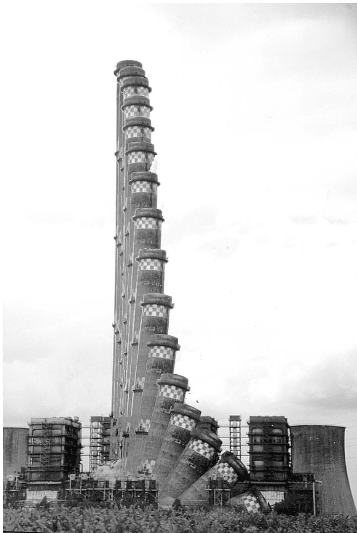
Bild 2: realisierte Einsturzfigur des 250 m hohen Schornsteins im Kraftwerk Hagenwerder (exakte Fotomontage)
