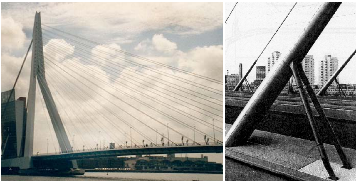
Abb. 1: Links: Schrägseilbrücke Erasmus Brücke , Rotterdam; rechts: passive Dämpfer (viskose Dämpfer) an der Schrägseilbrücke Erasmus Brücke
