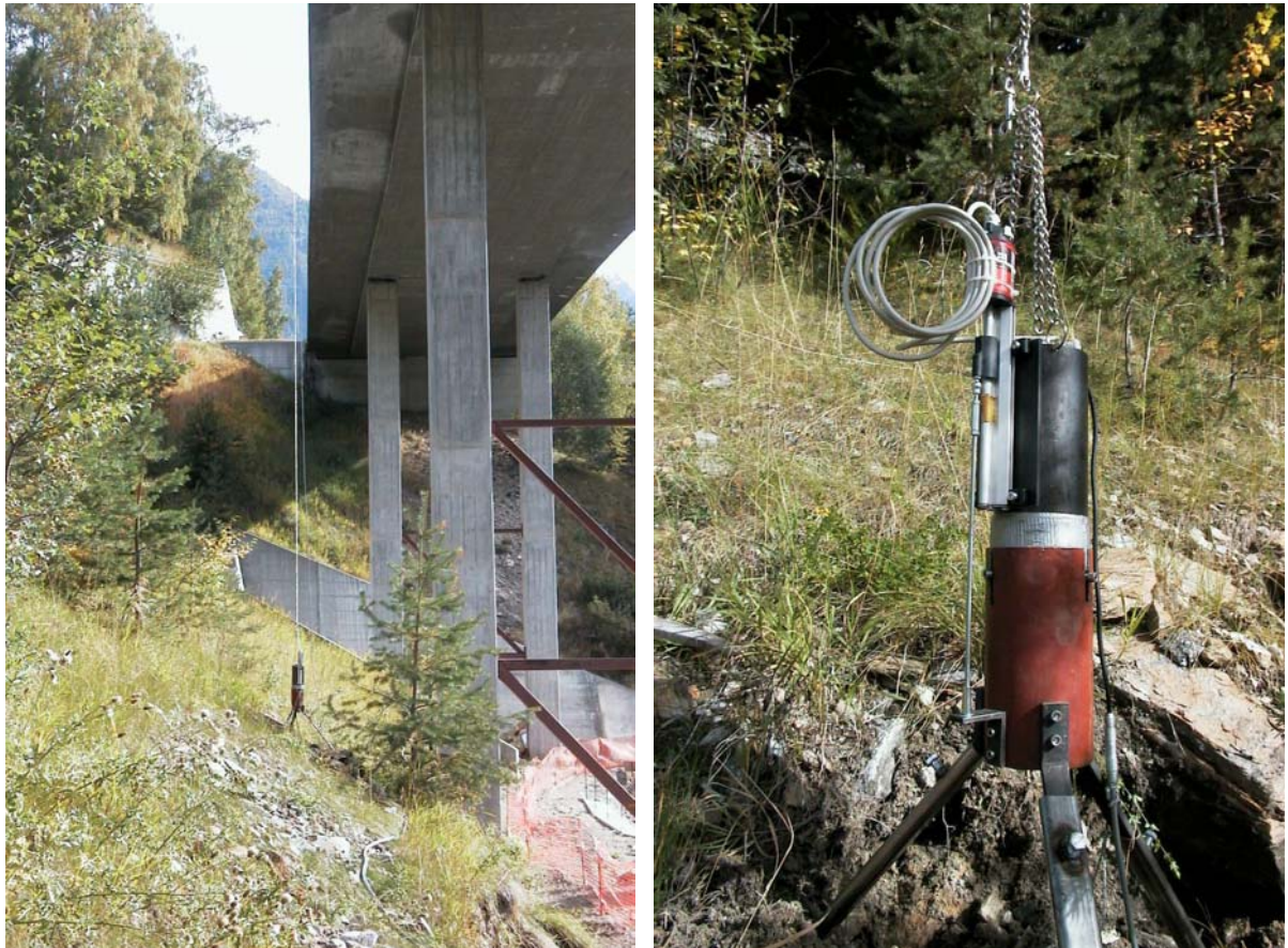
Abb. 3-3 und 3-4 Wegsensor zur Messung der statischen Einsenkung d_{stat} der Brücke
