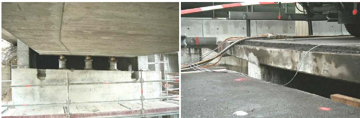
Abb. 11: Links: Lagerung des Brückenträgers auf drei hydraulischen Pressen. Rechts: Absenkung des Brückenträgers am Widerlager Nord um ca. 60 cm.
