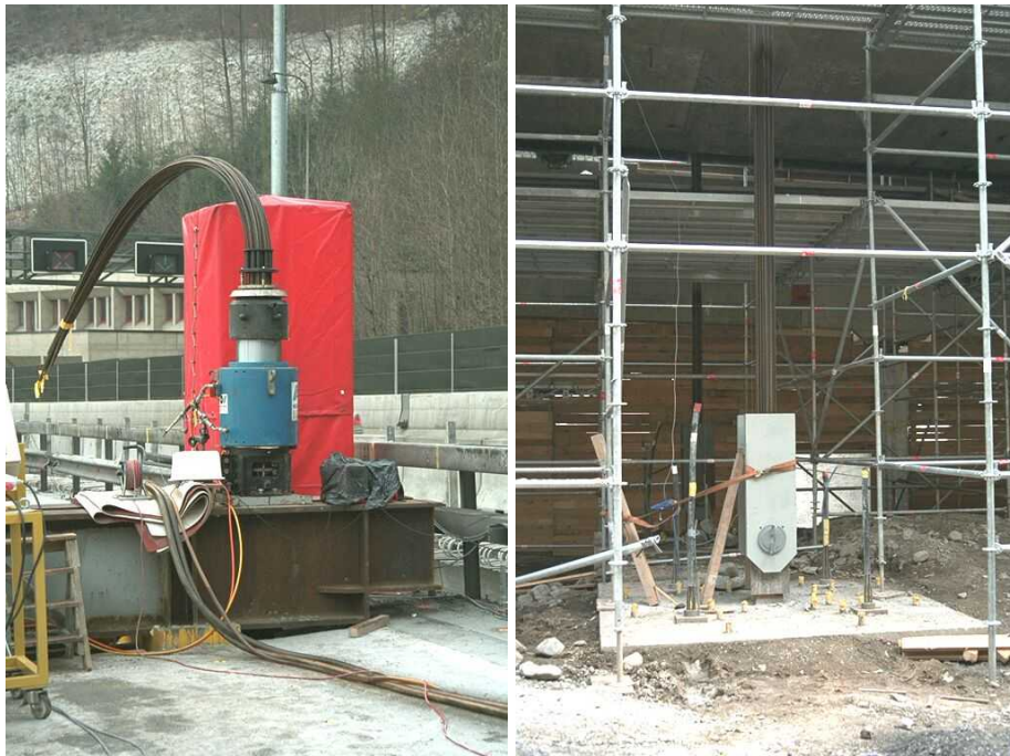
Abb. 12: Links: Hydraulische Presse zur Spannung der Vorspannkabel. Rechts: Verankerung der Vorspannkabel am Fundament.
