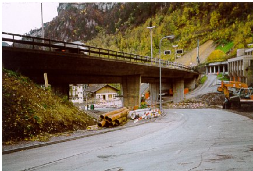
Abb. 1: Ansicht der Brücke "Romeo".
