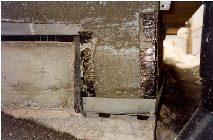
Detail der isolierten Betonplatte mit Sicherung gegen Bergdruck
