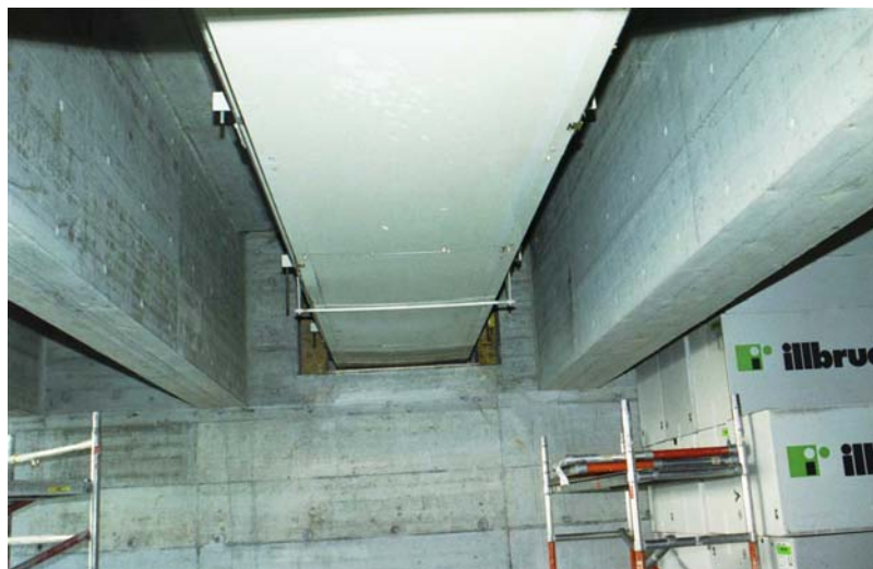
Bild 9 Eingebaute Rippen in der Werkstatt, in der Mitte ein Blechkanal
