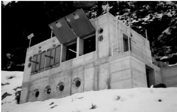
Figur 6 Bunker mit Beobachtungs- Bullaugen im Untergeschoss und vier Öffnungen im Obergeschoss für die Radarmessungen. Die Öffnungen können mit Stahlklappen geschlossen werden
