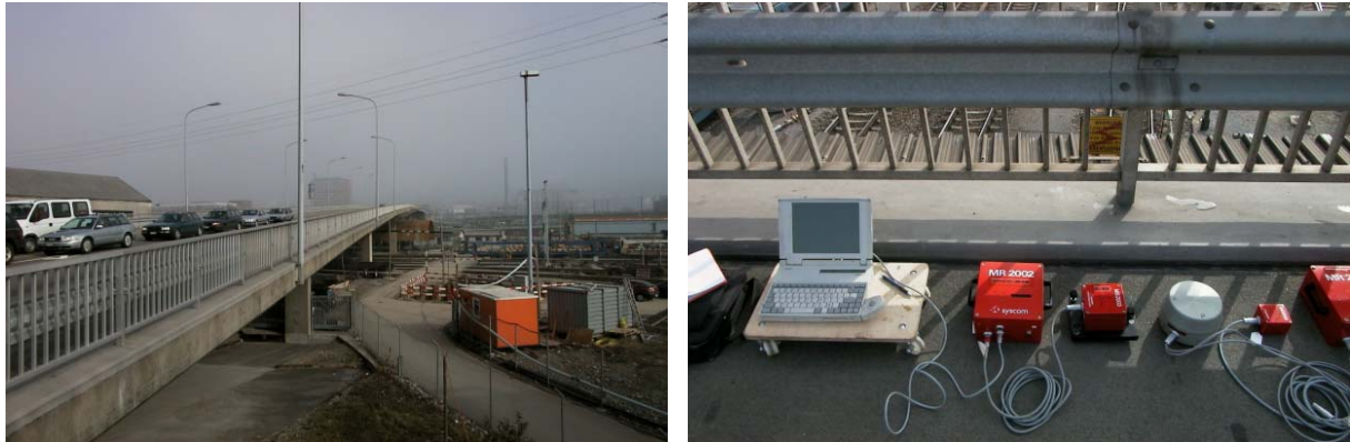
Bild 4.1a,b Erschütterungsmessungen für eine Strassenbrücke; rechts : MR2002 mit den Sensoren MS2003, WB2000 und MS2002.
