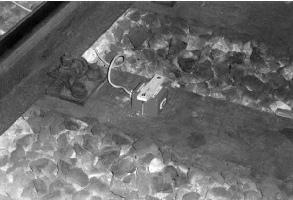
Bild 9: Detail Messquerschnitt „A“ Schwellenmesspunkt „Vertikal“
