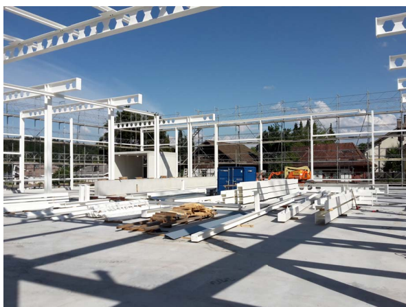
Bild 3.6a Baustelle zum Zeitpunkt der Admittanzmessung
