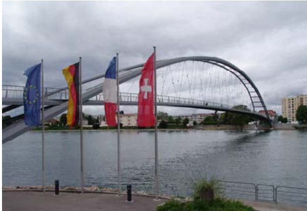
Bild 9.1a Dreiländerbrücke / Weil am Rhein
