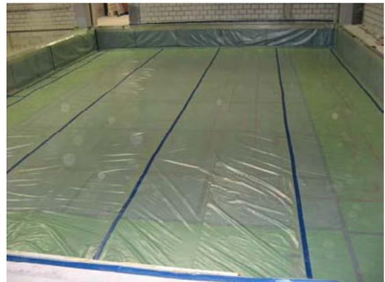
Fundamentwanne mit PU-Schaum-Auskleidung
