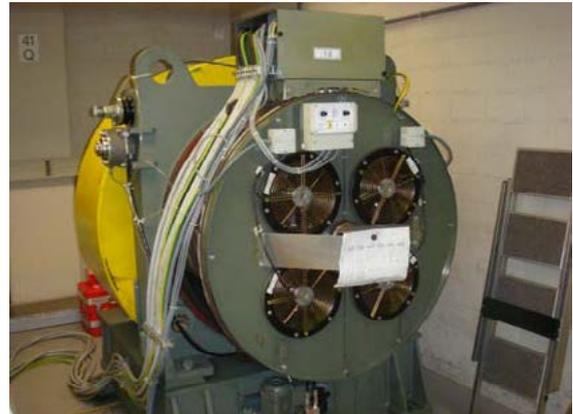
Die Messungen ergeben bei Voll-Last maximale Schwinggeschwindigkeiten von 12.3 mm/s bei 4.4 Hz. Durch Integration des Geschwindigkeitssignals erhalten wir eine maximale Wegamplitude von 0.39 mm.
