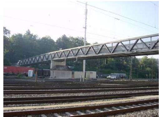
Die Wylandbrücke ist zwar ein 2-Feld-Träger, doch lässt sich die Eigenfrequenz für die beiden Teile approximativ berechnen, indem man jeden Teil als einfachen Balken betrachtet. Wie in Kap. 4 beschrieben, berechnet sich die Eigenfrequenz des einfachen Balkens nach:
