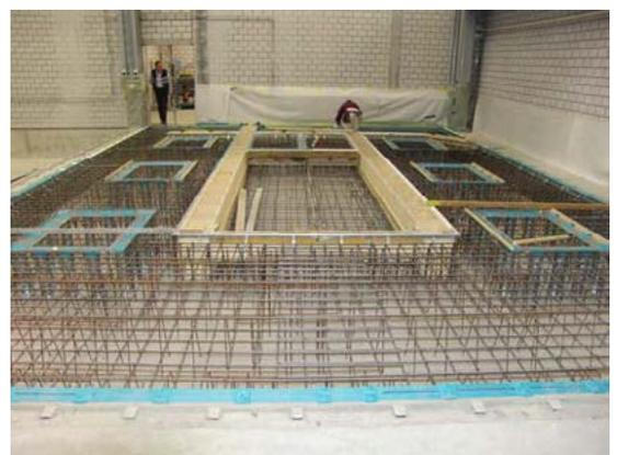
Armierung für die zweite Hälfte des Betonblocks
