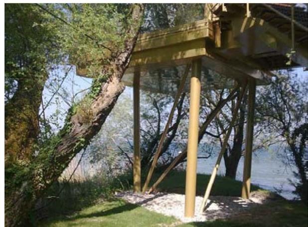
**Bild 4** Verstärkung durch Diagonalen
