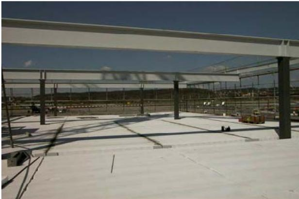
Bild 1 Gasbeton-Platten für die Geschosdecke des Busterminal
