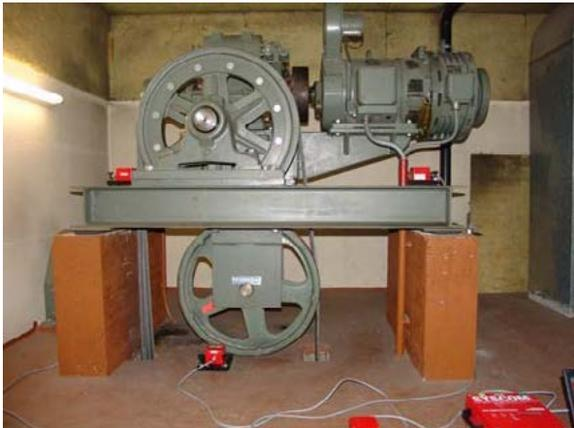
Bild 1 Elastische Lagerung eines Liftmotors
