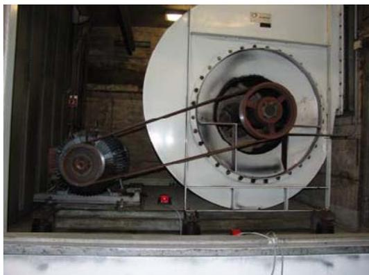
Bild 3 Ventilator der Lüftungseinheit F-100
