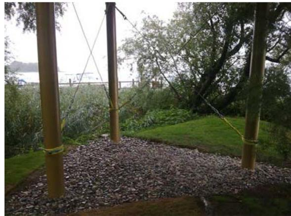
**Bild 2** Provisorische Verstärkung durch Abspannungen
